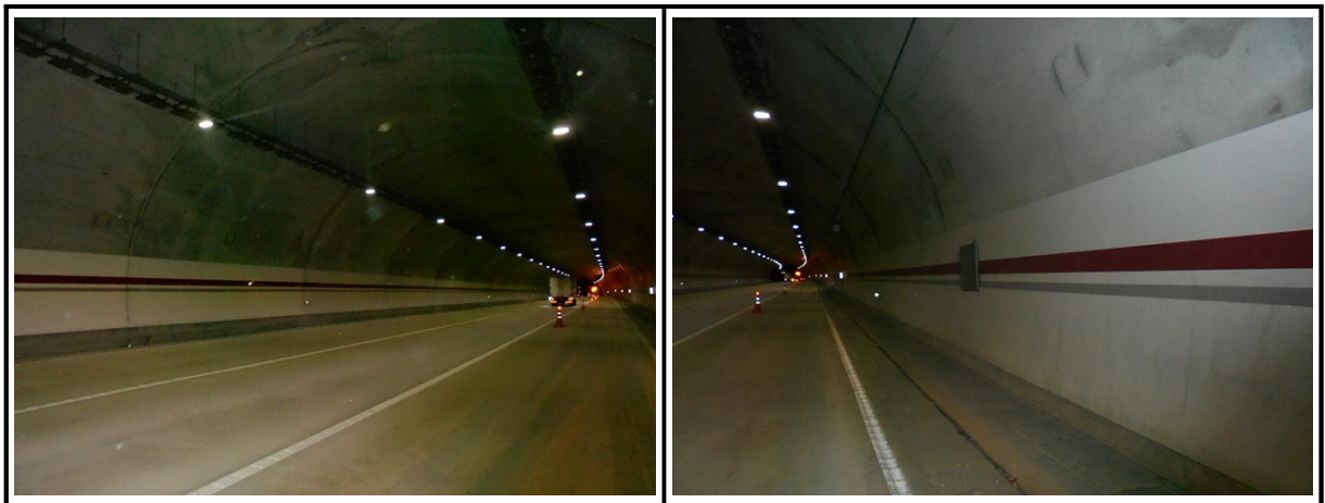
【사진 2.3.16】 라이닝 측벽부 전경
