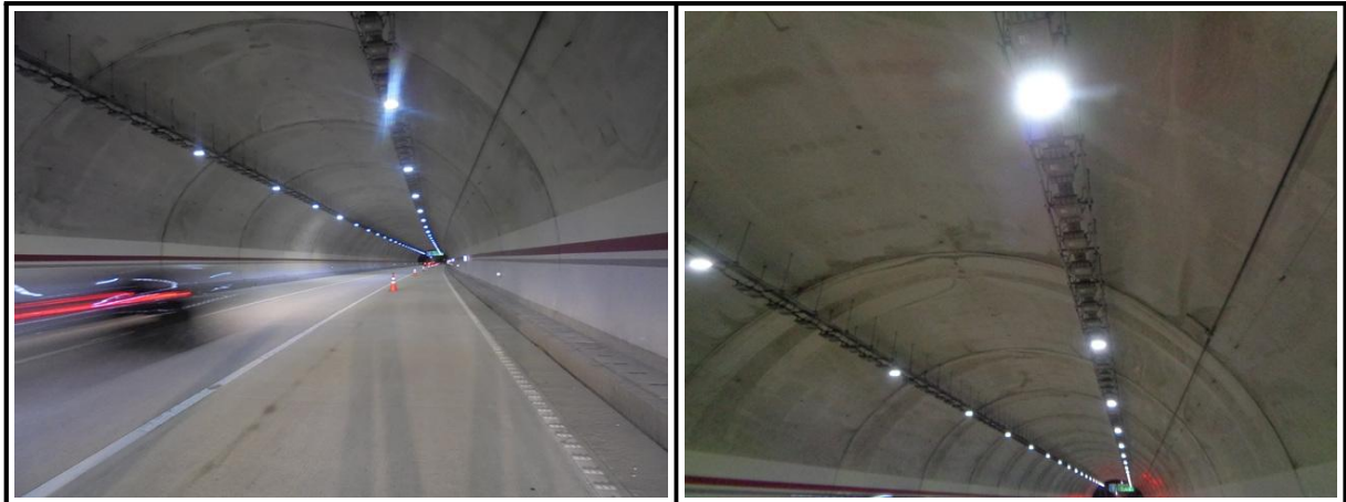
【사진 2.3.1】 라이닝 천단부 전경
