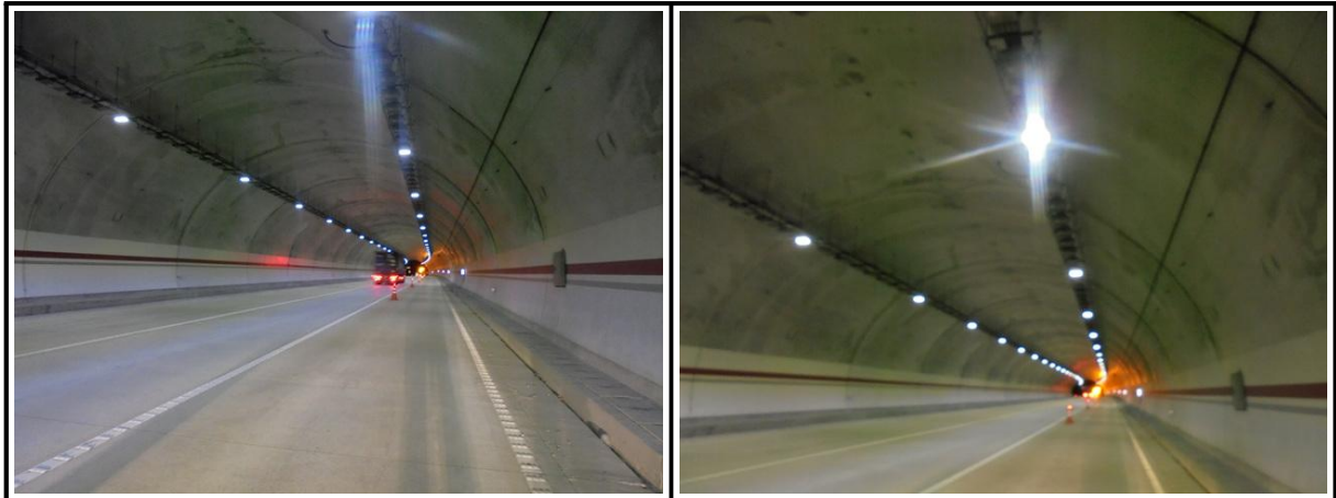
【사진 2.3.14】 라이닝 천단부 전경
