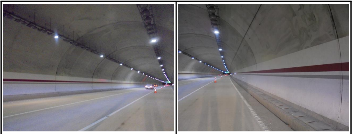
【사진 2.3.3】 라이닝 측벽부 전경
