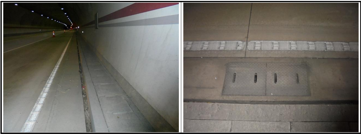
【사진 2.3.21】 공동구 및 배수시설 전경
