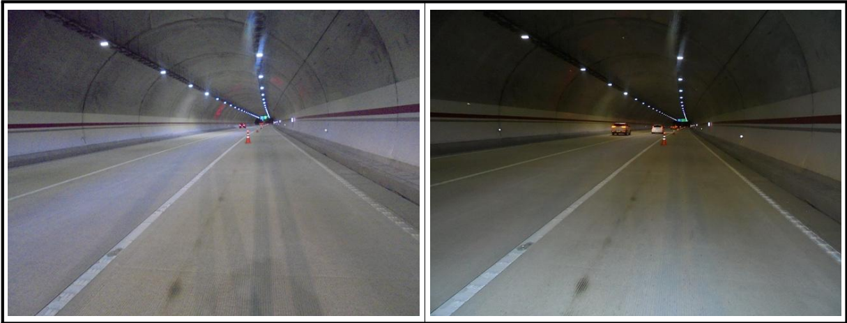
【사진 2.3.10】 포장부 전경
