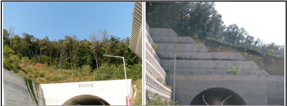
【사진 2.3.20】 사면 전경
