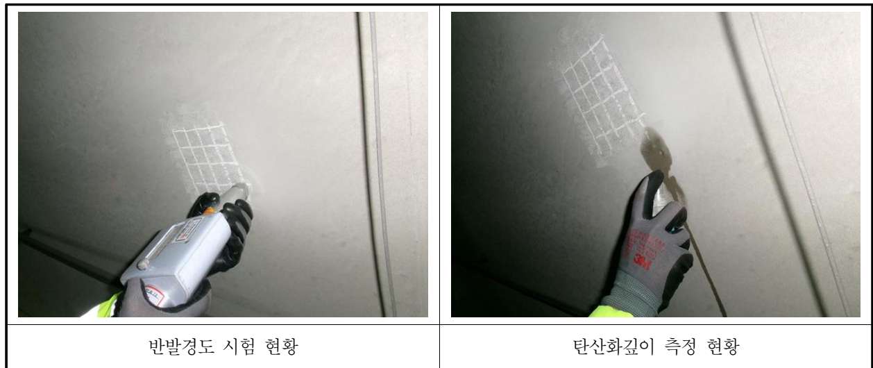
【사진 2.4.1】 콘크리트 내구성조사 현황
